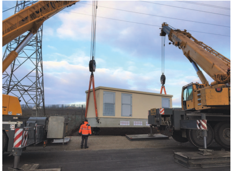
Zano: Opbau vun enger vun de neien Trafo-Stationnen
