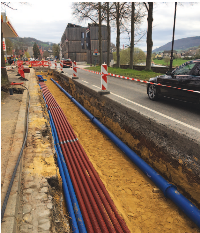
Avenue de la Gare: Erneuerung von de Waasser- a Stroum-Leitungen an der Kollektiv-Antenne
