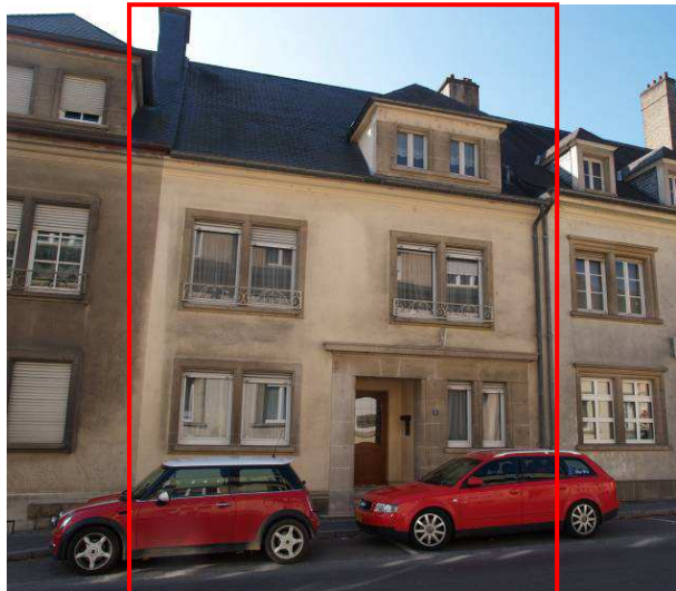
8, rue de Stavelot
