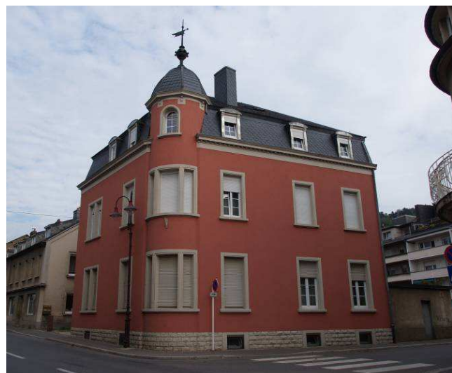
21, rue de Stavelot
