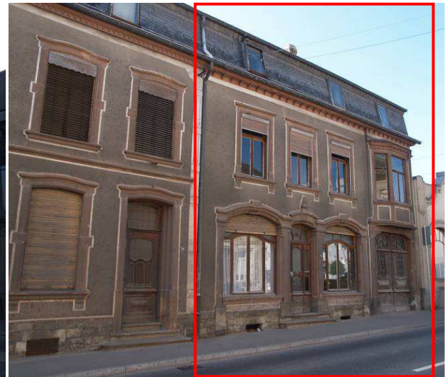
24, rue de Stavelot
