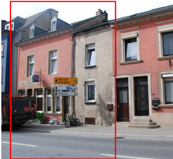
44-46, rue de Stavelot
