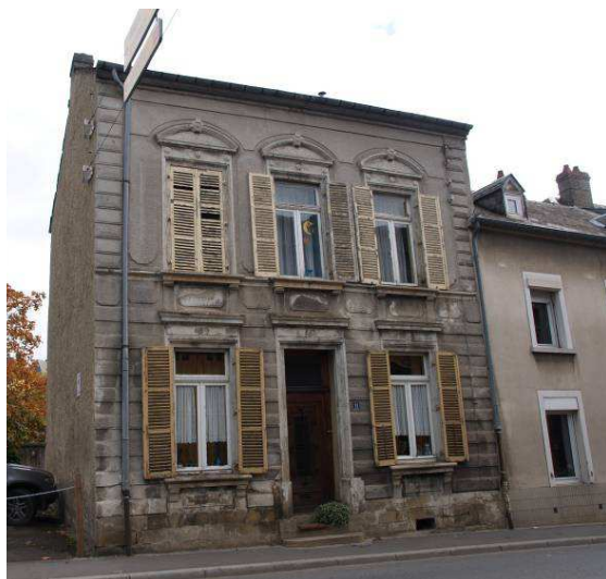
11, rue de Stavelot
