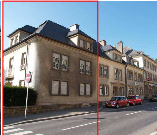
10, rue de Stavelot
