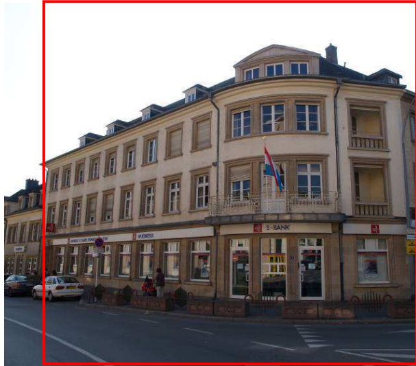
2-4, rue de Stavelot
