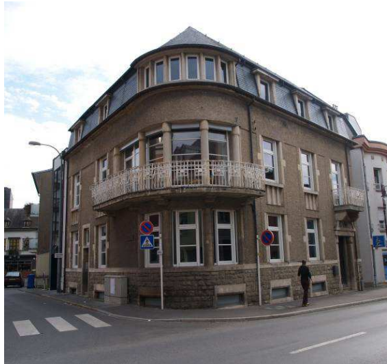
23, rue de Stavelot
