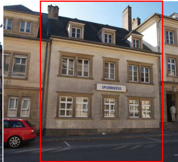
6, rue de Stavelot
