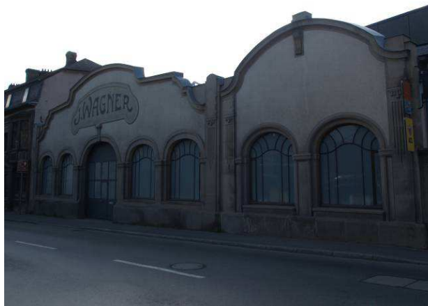
22, rue de Stavelot
