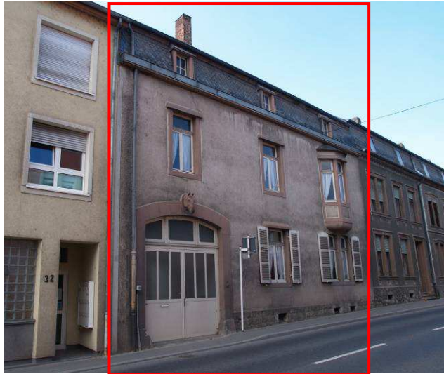
30, rue de Stavelot
