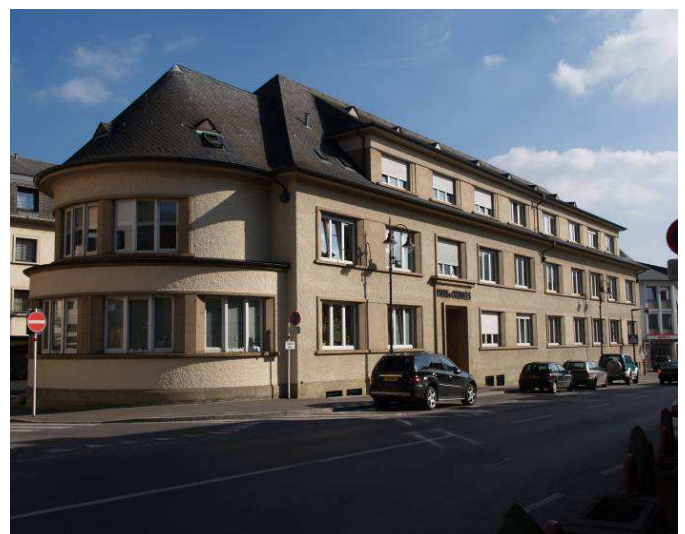
1-3, rue de Stavelot
