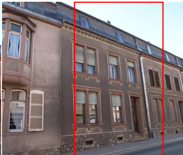
28, rue de Stavelot
