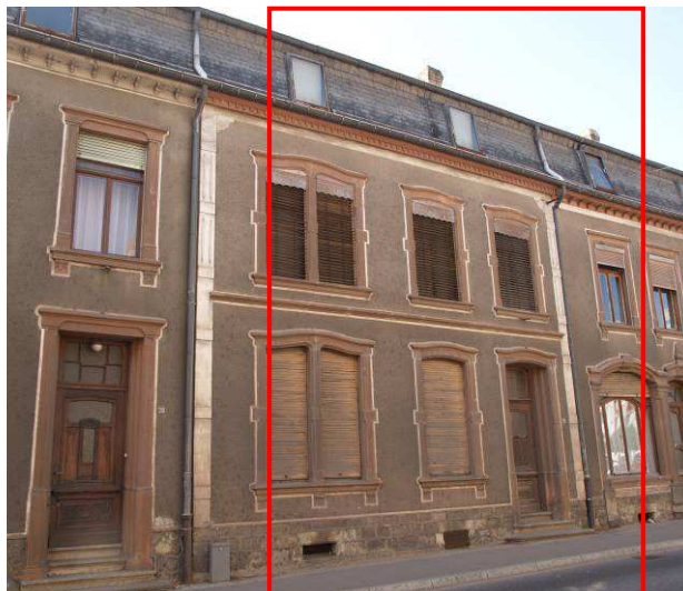
26, rue de Stavelot
