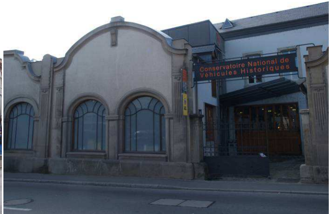
20, rue de Stavelot
