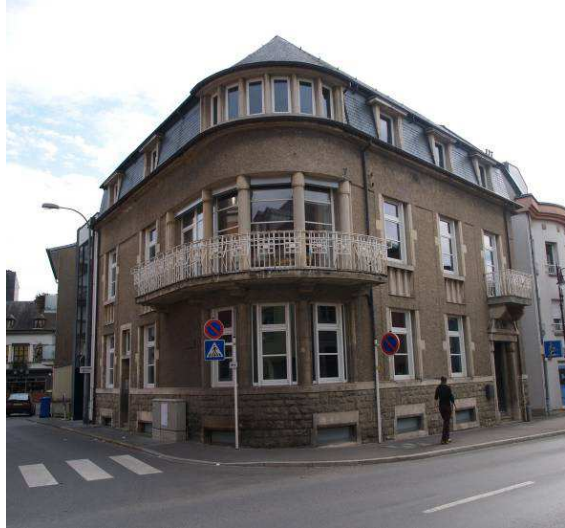
23, rue de Stavelot
