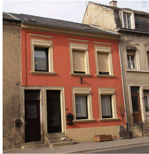
42, rue de Stavelot
