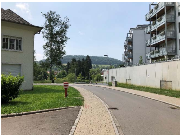
Voirie en direction de la promenade de la Sûre
