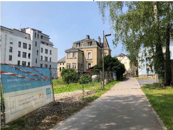
Connexion piétonne vers rue Alexis Heck
