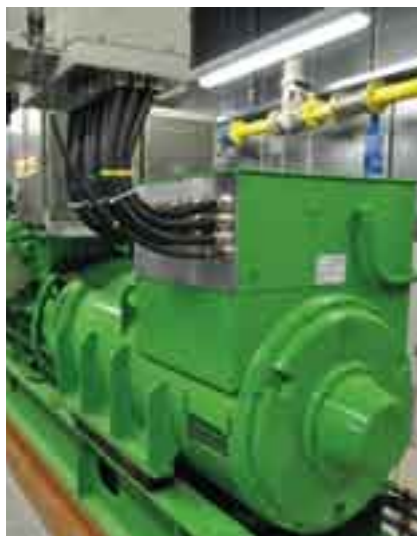
Die 3 Erdgasmotoren stehen im neuen Ausbau der Energiezentrale auf dem Gelände des Service Industriel in der „Sauerwiss“. Die ersten Testläufe liefen erfolgreich. Neben umweltfreundlicher Energie liefert die moderne Wärmekraftkopplungsanlage der Stadt Diekirch auch wichtige Einnahmen.
