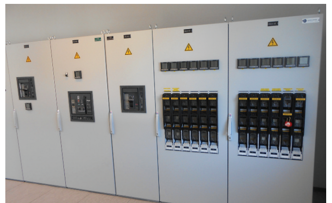
Niederspannungshauptverteilung
