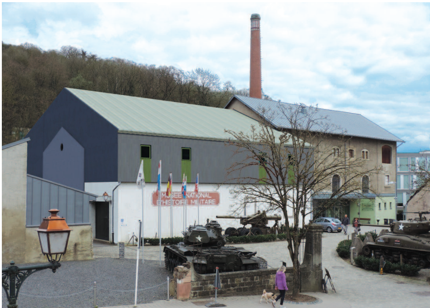
Façade principale après la finition des travaux d'extension prévue pour printemps 2017
