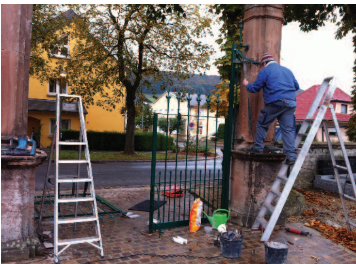
Restauration des clôtures / portes du cimetière
