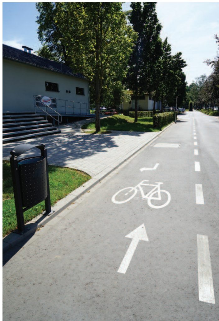
Route d'Ettelbruck: nei Markiierung vun der Piste Cyclable
