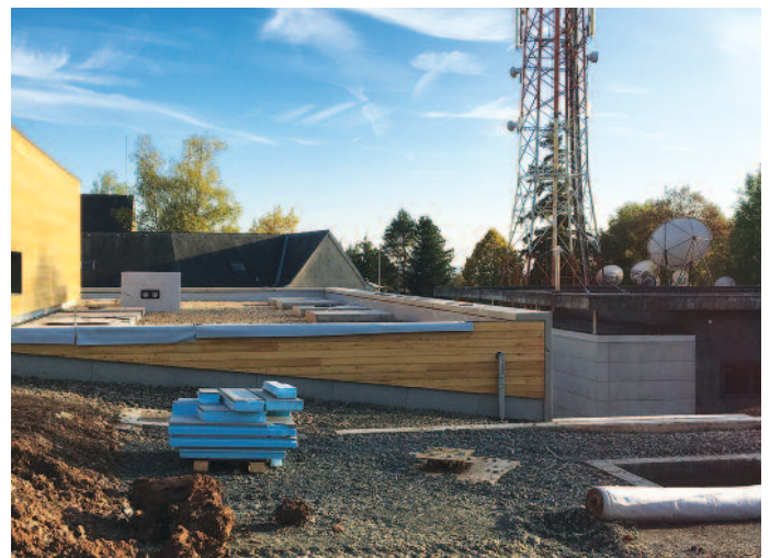
Installation d'un nouveau mât d'antennes au Herrenberg
