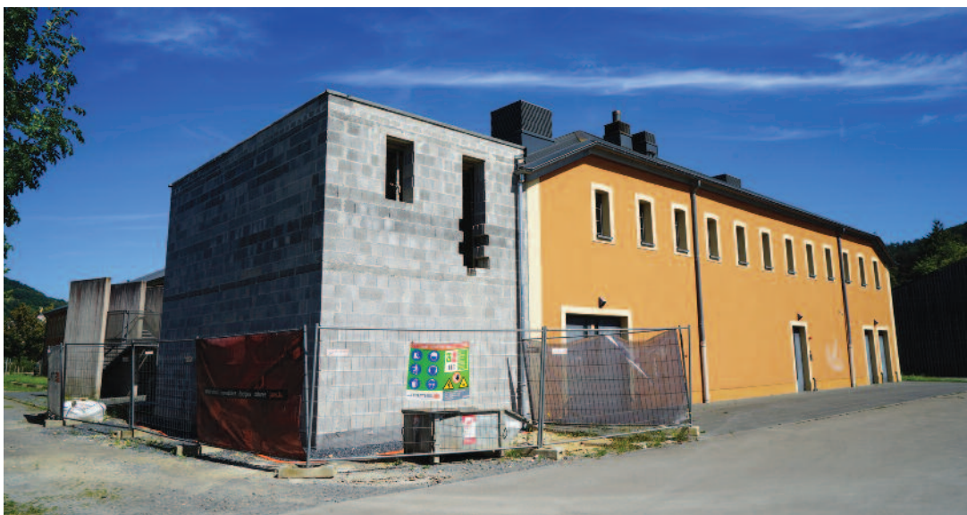
Extension du bâtiment «Al Seeërei» permettant le stockage de matériaux / mobilier
