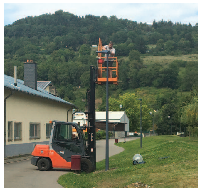
Remplacement de l'éclairage conventionnel le long de la Sûre par un luminaire LED
