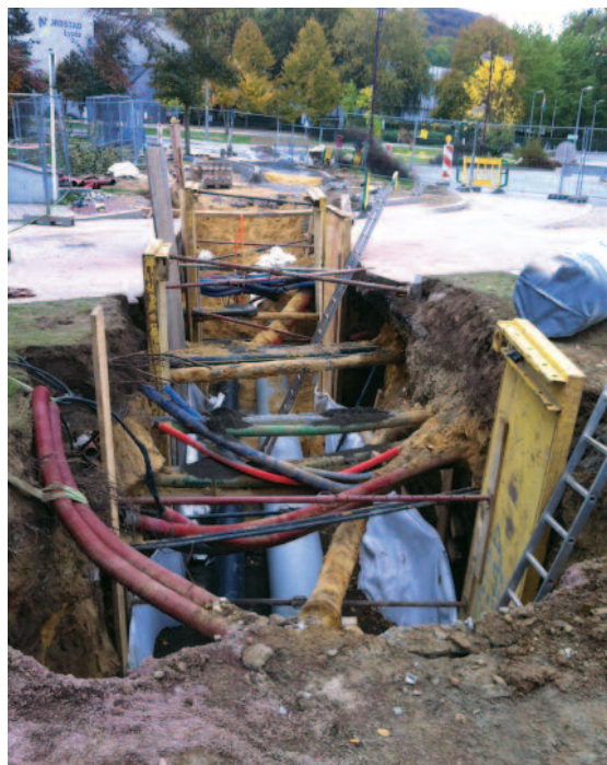
Rond-point Route de Gilsdorf / Chemin Loumillen à Diekirch: Pose de la canalisation pour le Lycée Technique Agricole en construction par l'Etat au site «Kréiwinkel» à Gilsdorf
