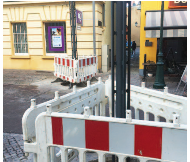
Réaménagement des portails pour la plantation de nouvelles plantes grimpantes au centre de la Ville
