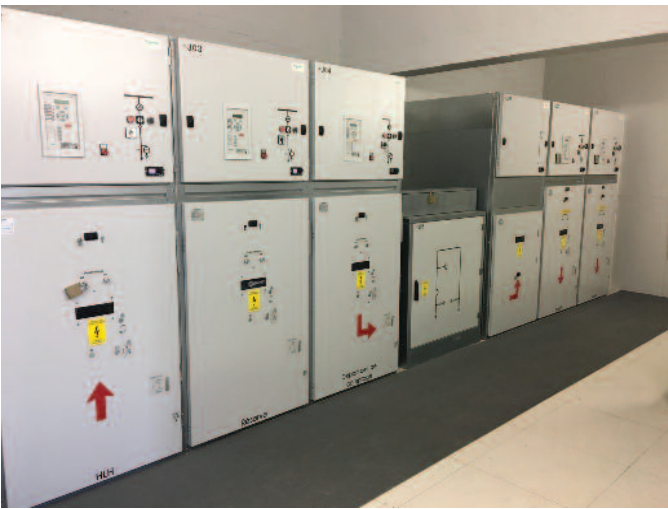
Caserne Grand-Duc Jean au Herrenberg: Construction d'un local technique pour la nouvelle station de captage et d'un poste de transformation électrique
