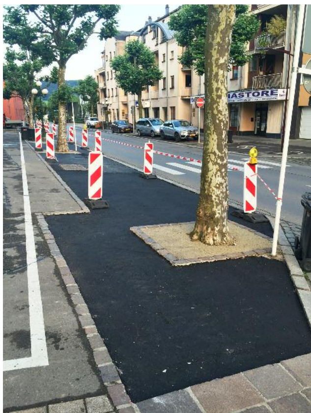
Place Wirtgen: Réaménagement vun der Parkingsplaz
