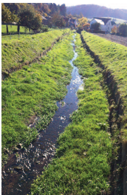
(Foto links) Dat 2004/2005 bei den Héichwaasserschutzmoosnahmen un der Tirelbaach breet ugeluechte Bett bis virun déi fréierer Eisebunnsbréck (± 5 Meter breet)
