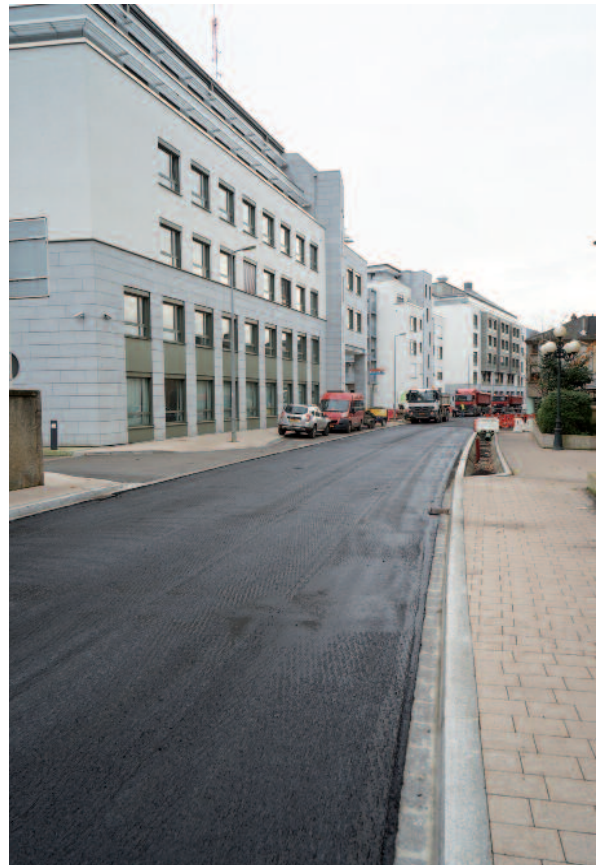
Komplett Erneuerung vun der Rue Alexis Heck
