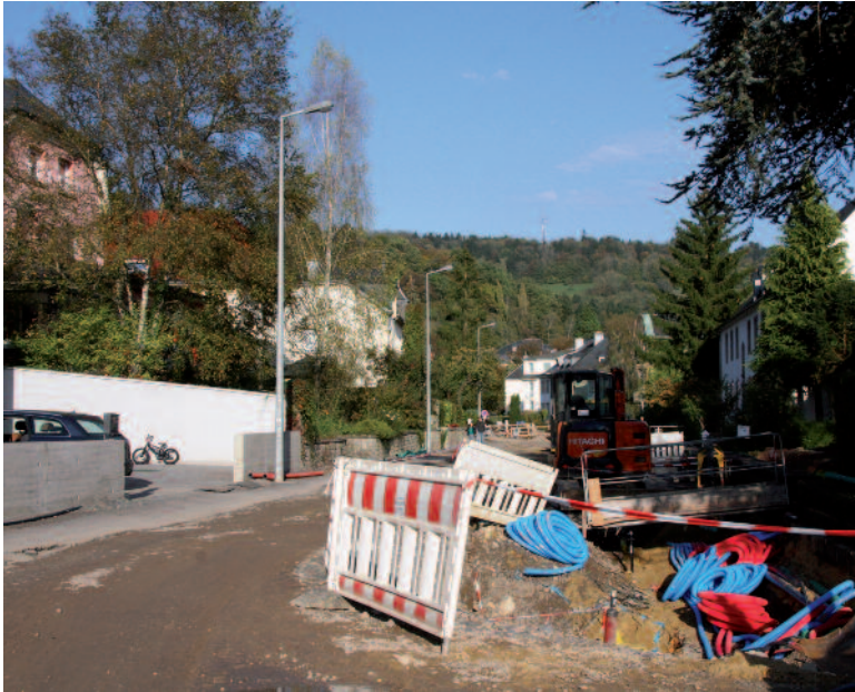
Infrastructuraarbichten an der Rue des Fleurs
