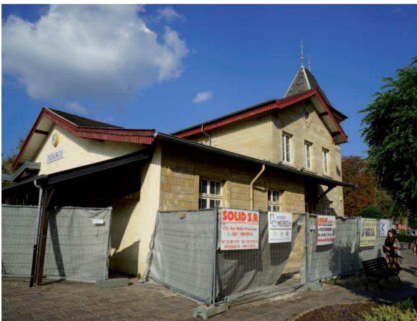
Embauarbichten an der Dikricher Gare
