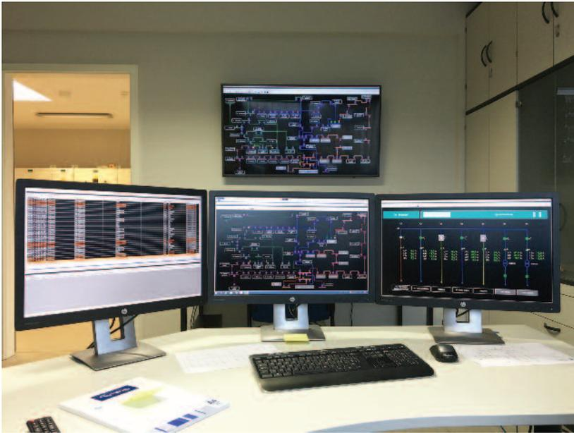
Services Industriels: Installation d'un nouveau système de télégestion du réseau de distribution électrique
