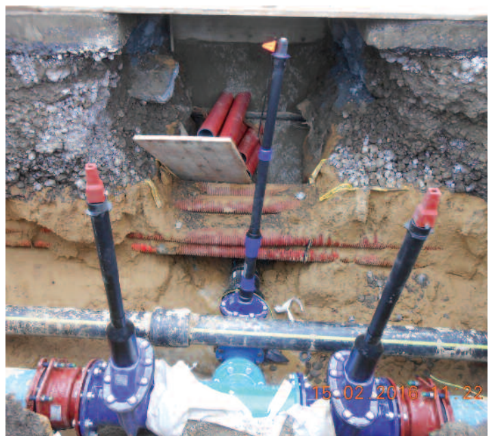
Installation d'une 3e conduite d'eau à travers la Sûre pour améliorer la sécurité d'approvisionnement en eau potable du centre de Diekirch. Prolongation et mise en service de la conduite d'eau potable en PEHD (diamètre extérieur \varnothing 180mm) installée dans le cadre des travaux du réaménagement du secteur "Al Schwemm", entre le lotissement "in Bedigen" et la route d'Ettelbruck
