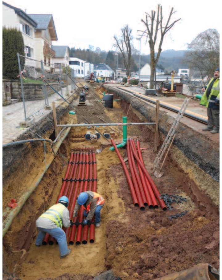
Rue Glaesener: pose de conduites et de gaines pour la viabilisation de la Zone d'Activités Economiques Fridhaff - ZANO
