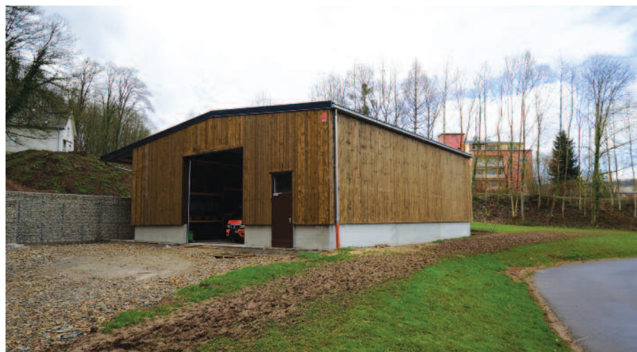
Stade municipal: construction d'un nouvel hall de stockage
