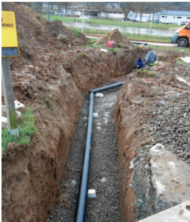
Installation d'une 3e conduite d'eau à travers la Sûre pour améliorer la sécurité d'approvisionnement en eau potable du centre de Diekirch. Prolongation et mise en service de la conduite d'eau potable en PEHD (diamètre extérieur \varnothing 180mm) installée dans le cadre des travaux du réaménagement du secteur "Al Schwemm", entre le lotissement "in Bedigen" et la route d'Ettelbruck
