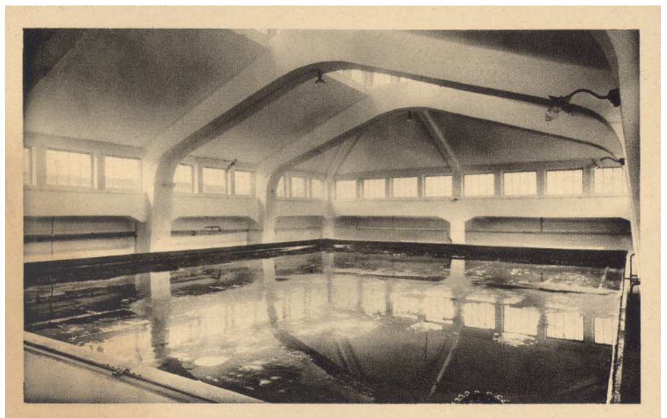
La S.A. Borsari & Cie. à Zollikon-Zurich, a construit une cave de fermentation de 8.100 HI et une cave de garde de 5.200 HI en béton armé avec le revêtement «Ebony» (26 cuves).
