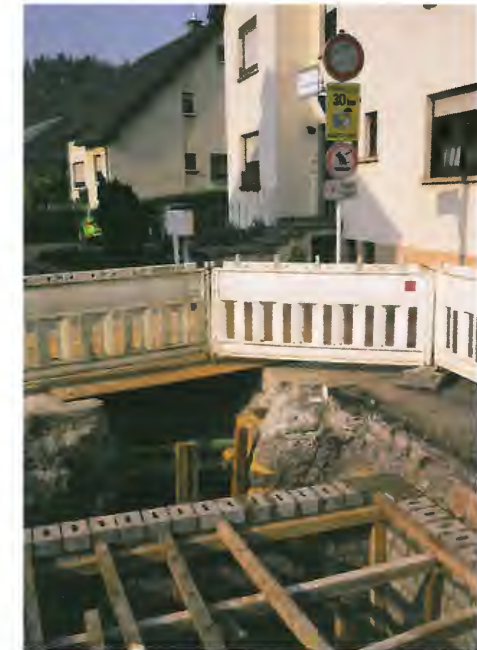
Installatioun vum Fernwärmenetz «Am Broch»
