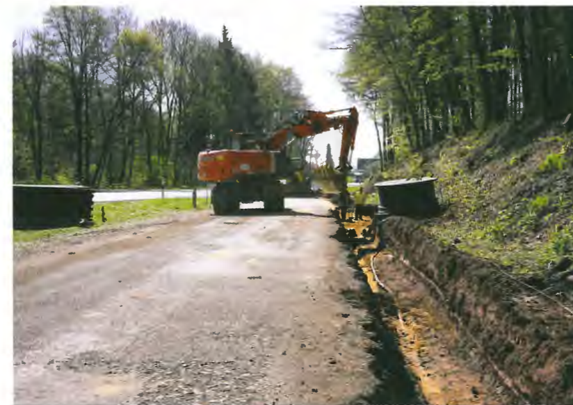
Erneuerung Wasserleitung Reservoir «Closdelt»-> Fridhaff
