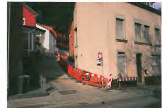
Verleeë vun neie Stroumleitungen am «Neelcheswee»
