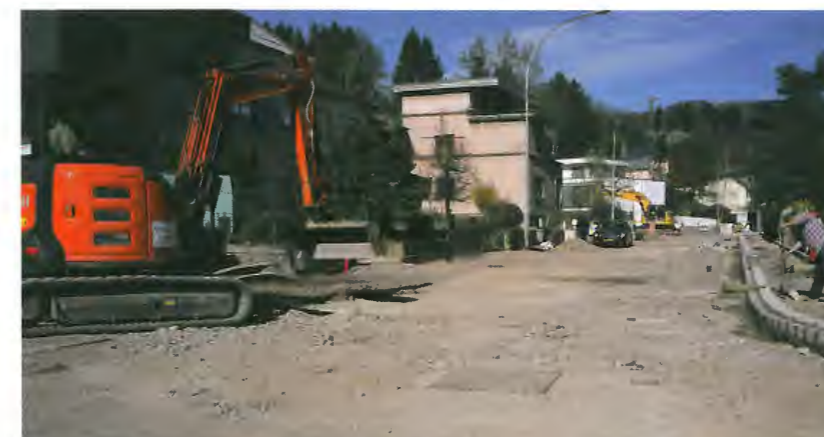
Infrastrukturaarbichten an der rue des Fleurs
