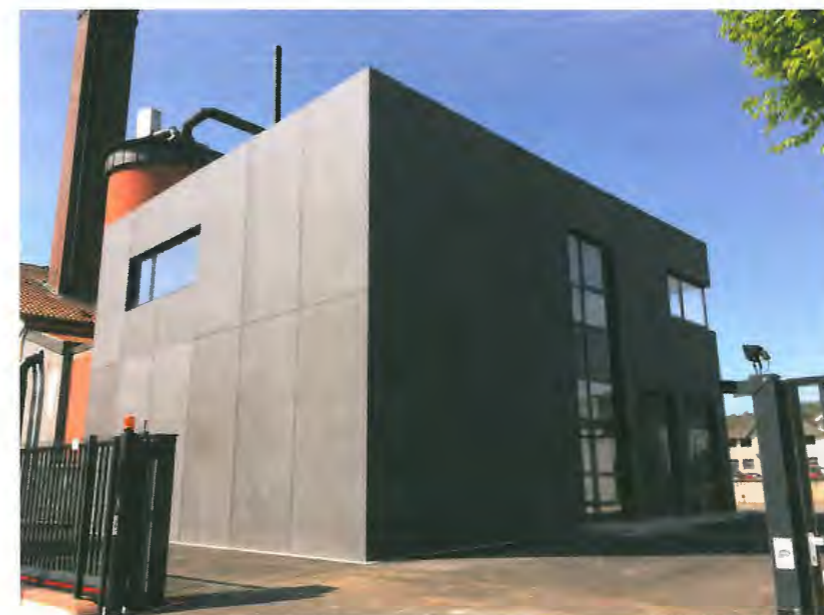
Neie Poste de Régie (Réseau de distribution électrique) - Areal Services Industriels - rue Sauerwiss
