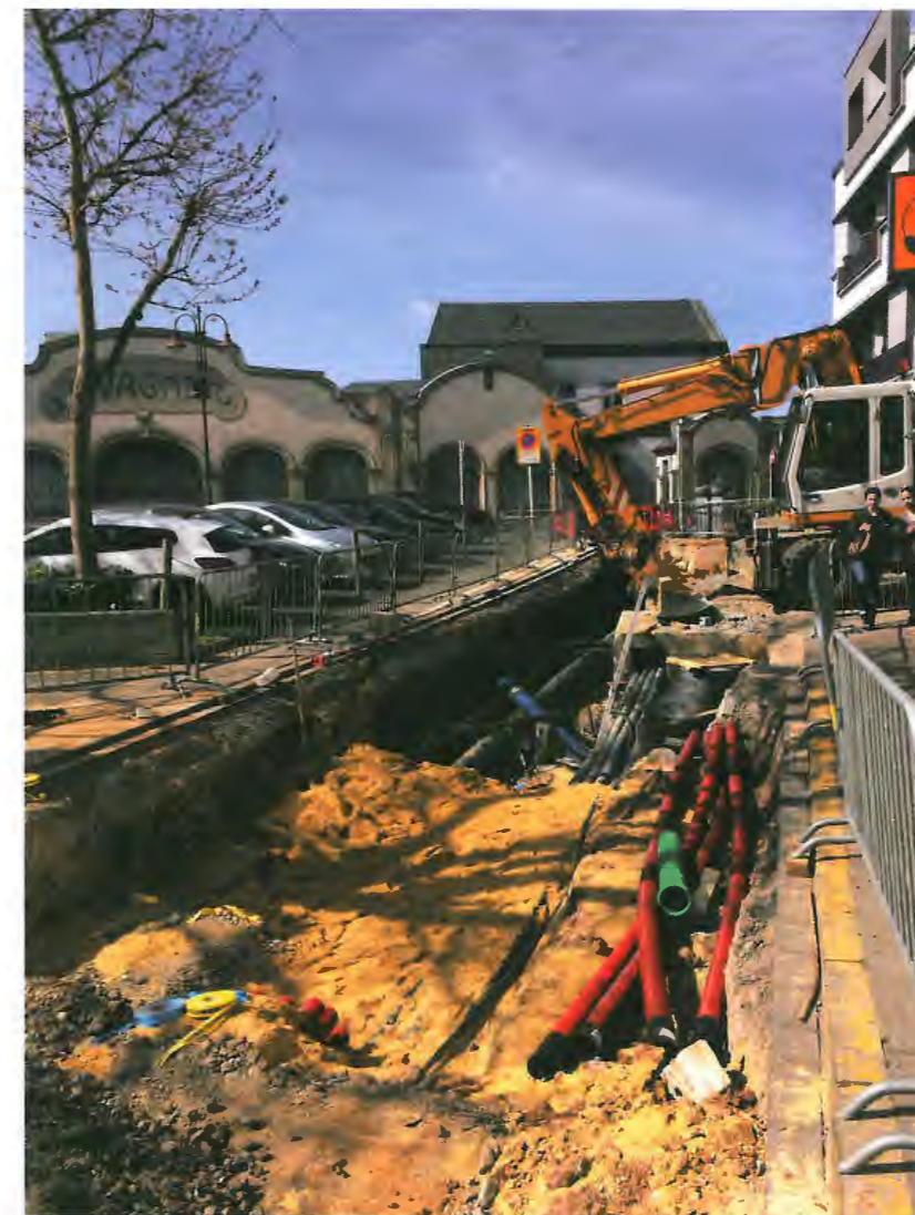
Infrastrukturaarbichten: Fernwärmenetz / Kanal / Elektrisch,... an der rue de l'Etoile
