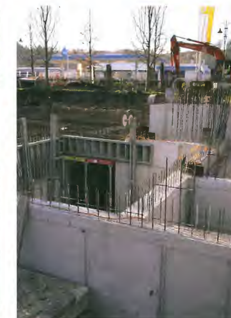
Bassin d'orages et vestiaires
