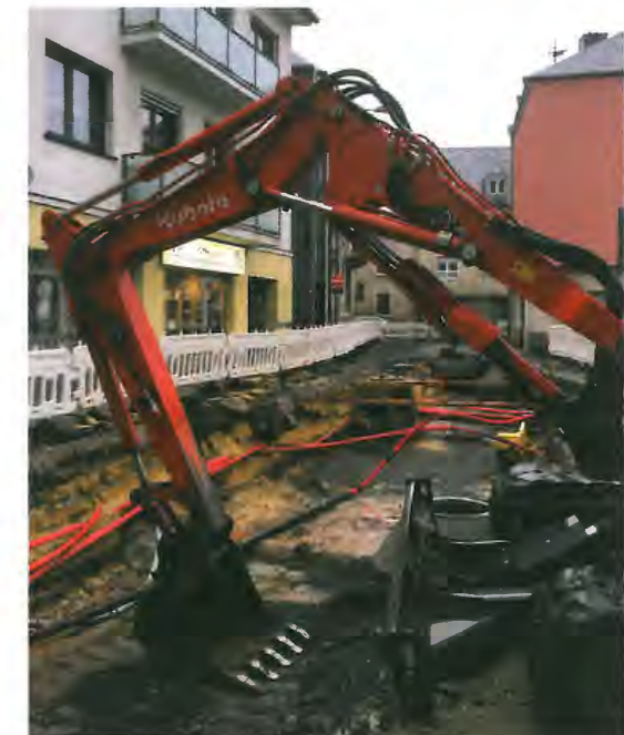
Infrastrukturaarbichten op der Place Goethals
