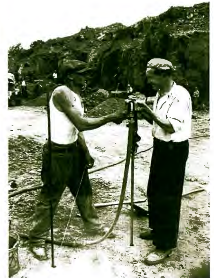
Das Bohren der Sprenglöcher
