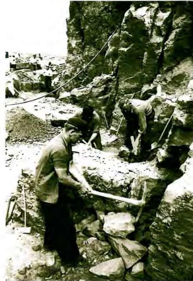
In eigenen Steinbrüchen auf dem Herrenberg wurden 11000 Kubikmeter Steine gebrochen
