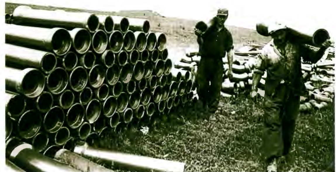
Eine echte Herausforderung war der Bau der Wasserleitung und der Kanalisation
