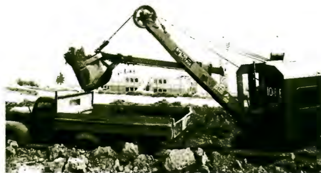
Riesige Lastwagen transportieren den überflüssigen Boden
