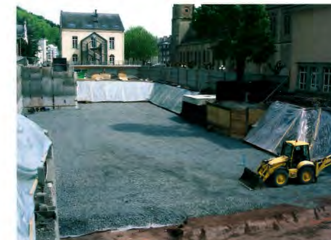
Terrassement pour le nouvel hall sportif photo: Paul Bonert
