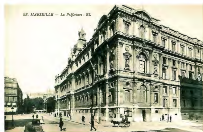
Préfecture in Marseille
