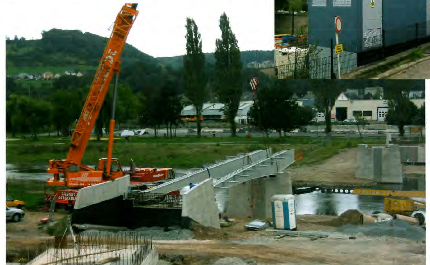
Opbau vun der neier Bréck an dem Regenüberlaufbecken (RÜB 3) an der Kléck ▼
