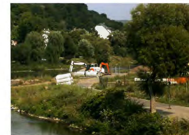
Ënnert de Rittwee gi nei Kanalrëier geluegt
