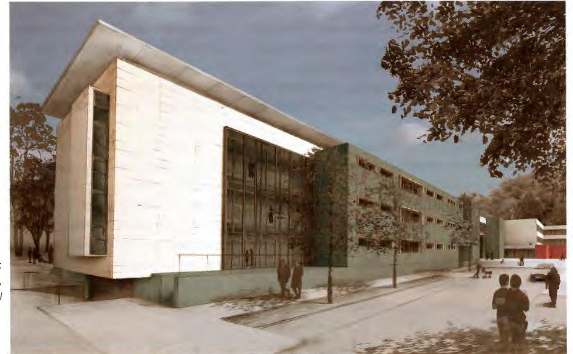
Gebäude A: Tiefgarage, Structure d'accueil
