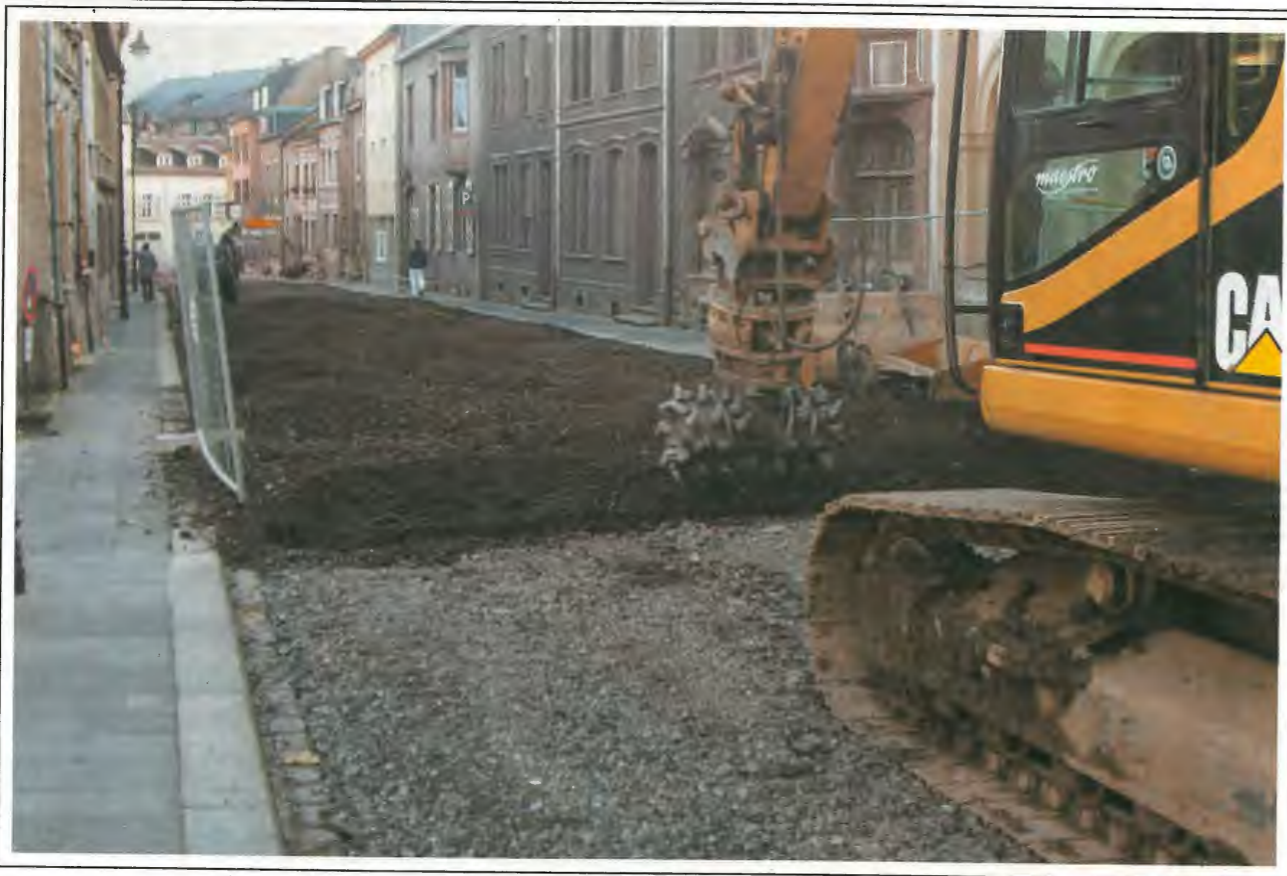
Mëtt November hunn d' Infrastruktuurarbechten am Gruef ugefang
