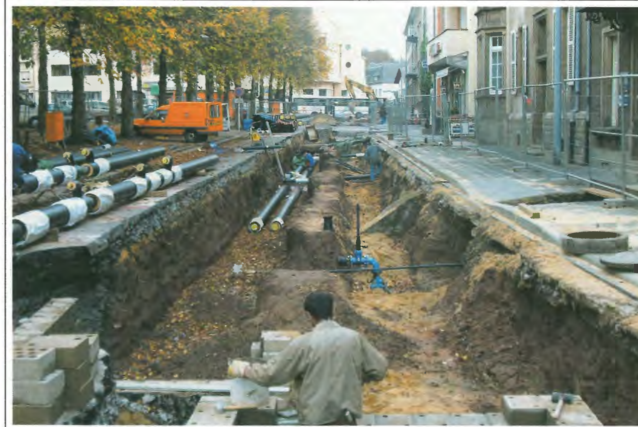
D'Aarbechte fir d'Fernwärmenetz an der rue Guillaume
