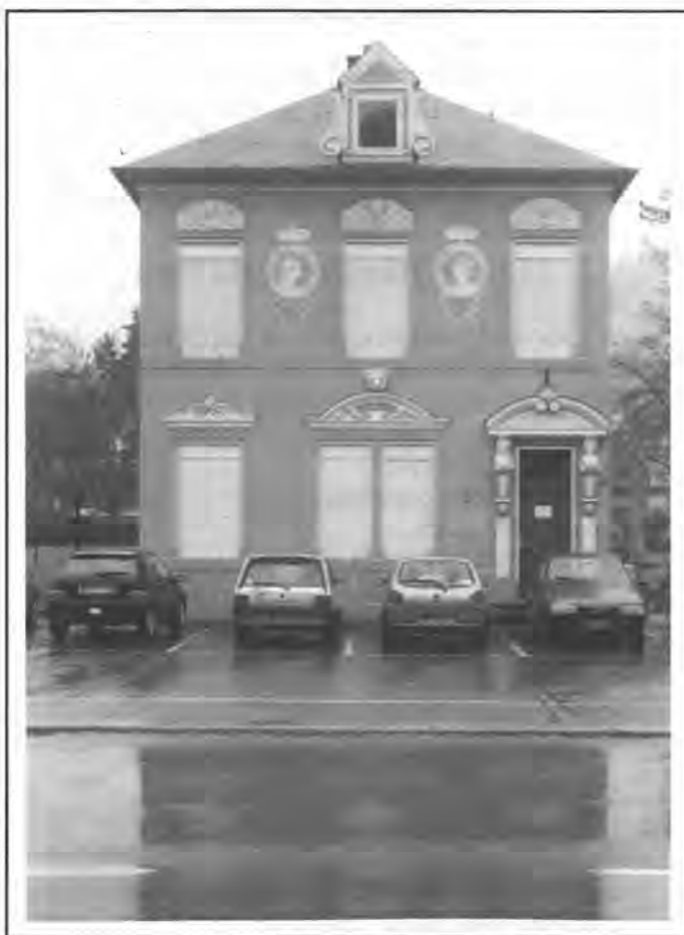
Maison Well (anc. Commissariat de Police)
