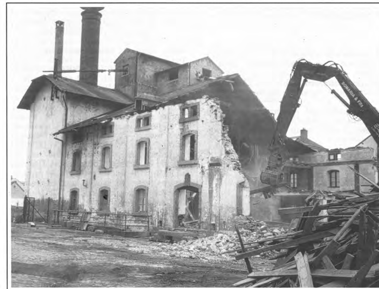
Janvier 2000: démolition de l'ancienne brasserie
