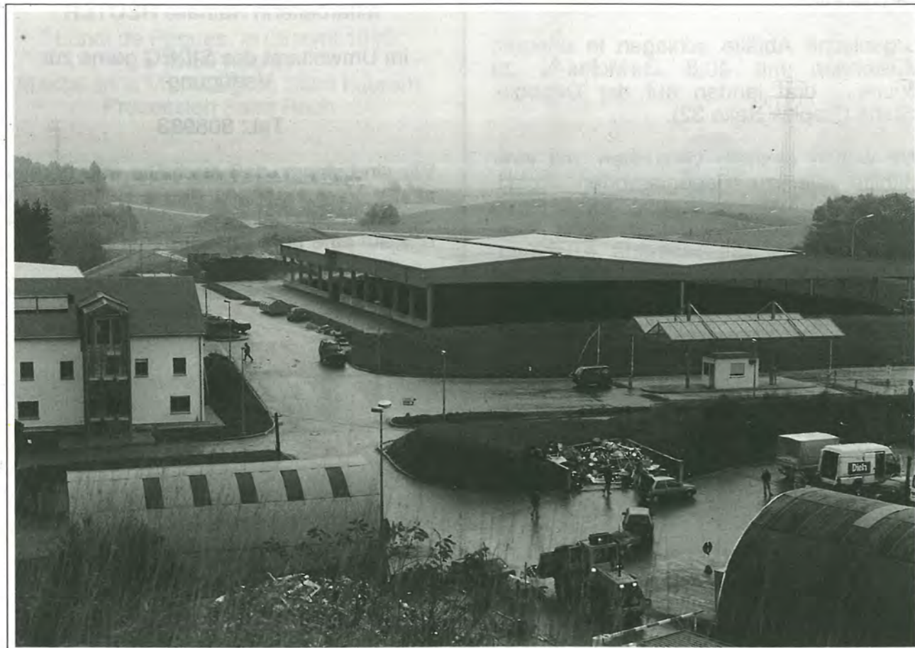
Die SIDEC Kompostierungsanlage
