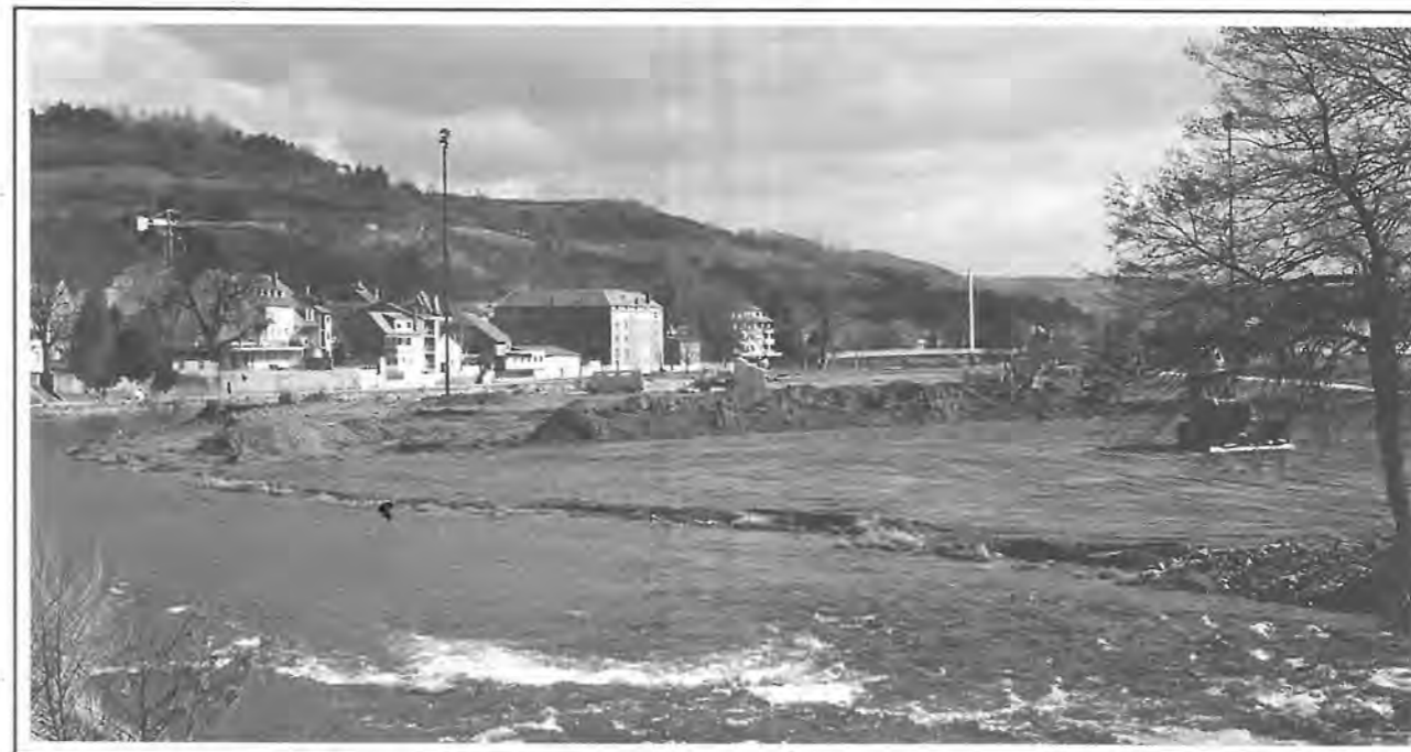
"Spidolswiss" fin février 98, dans le cadre des mesures de protection contre les inondations (étape 98)
