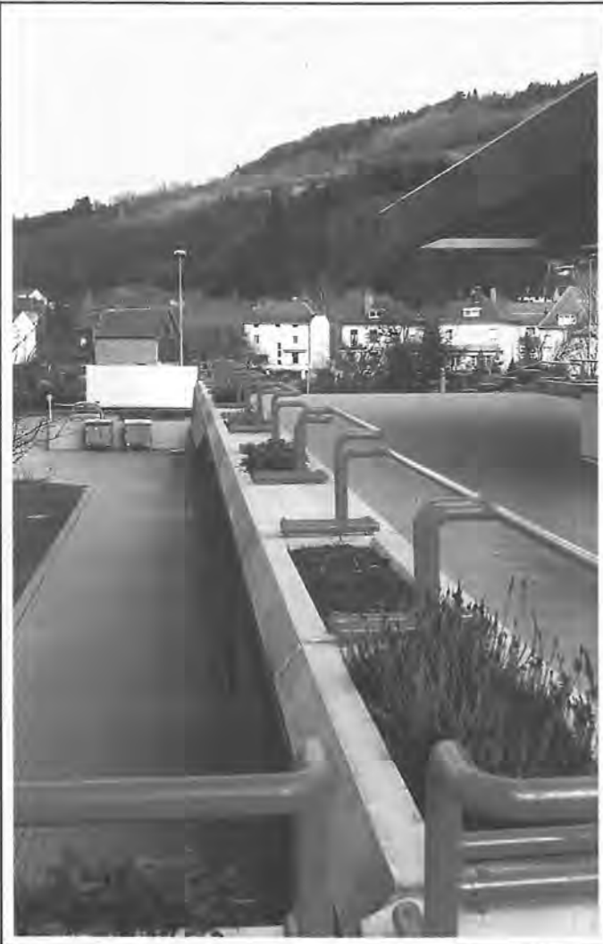
Centre sportif: remplacement des garde-corps sur la terrasse
