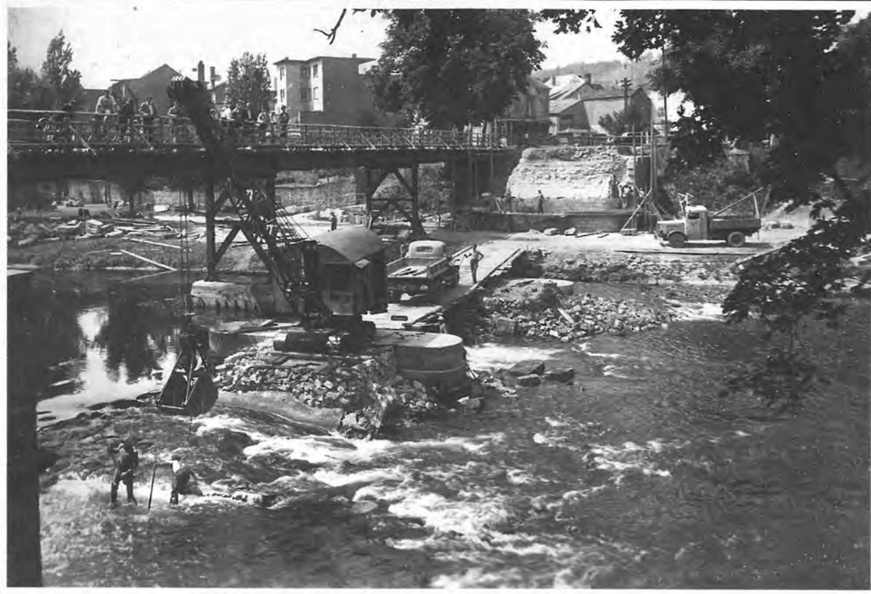
Démolition des restants de l'ancien pont et curage du lit de la Sûre 1947
