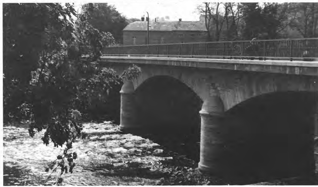
Le pont après sa reconstruction en 1948
