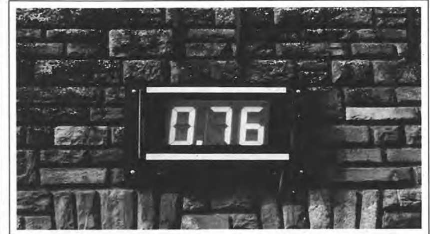
Digitale Anzeigetafel des neuen Pegels
