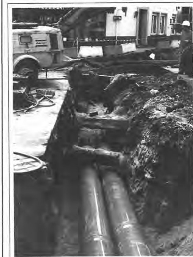
Travaux au réseau du chauffage urbain place de l'étoile - rue de la Croix 03 au 07 mars 1997
