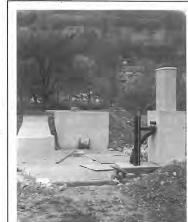
Aménagement d'une station à pompes (Camping)
