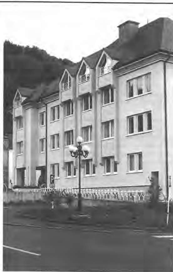
Bâtiment administratif, rue Clairefontaine
