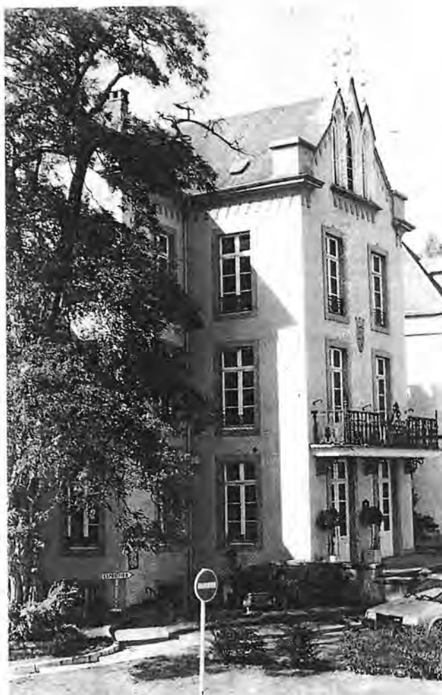
Le Château Wirtgen
