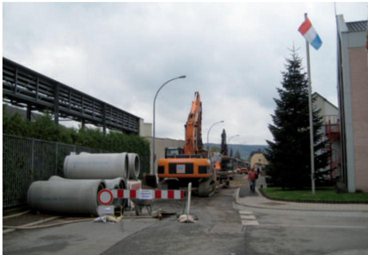
Uschloss vun der Industriestrooss un d'Gaznetz
