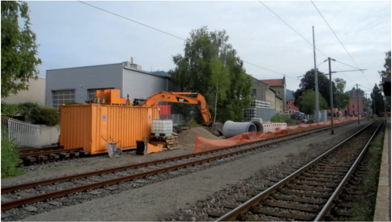
Verleë v unger neier Kanalisatioun laanst d'Gleiser vun der Gare bis an d'Rue de l'Industrie
