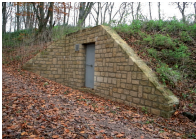
Réservoir d'eau «Closdelt»
