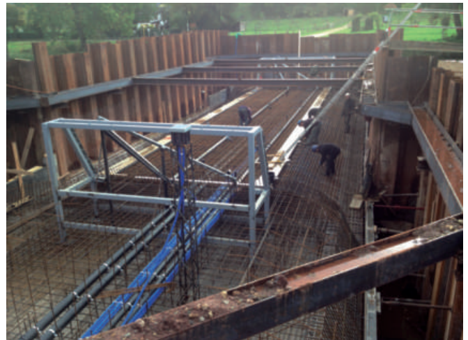
Letzte Vorbereitungen am Wehr vor dem Betonieren
