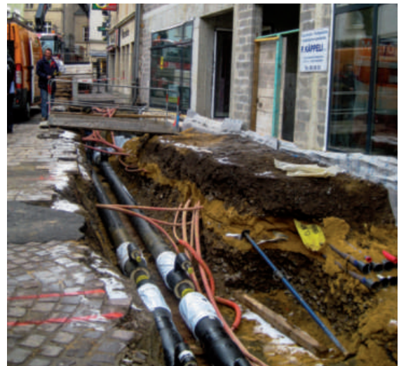
Uschluss vun der Antoniusstrooss un d'Fernwärmenetz
