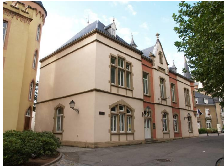
6, place Auguste Wirtgen
