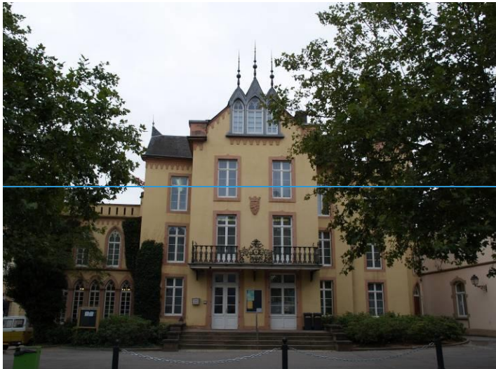
8, place Auguste Wirtgen
