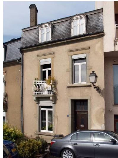
2, place Auguste Wirtgen
