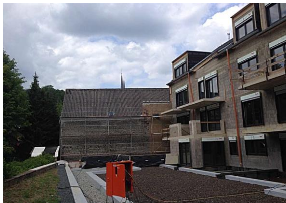
Rückwärtiger Bereich – Blickrichtung Nordosten
