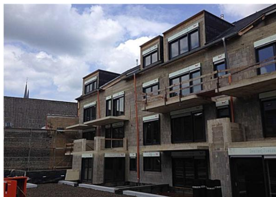
Rückwärtiger Bereich – Blickrichtung Nordosten
